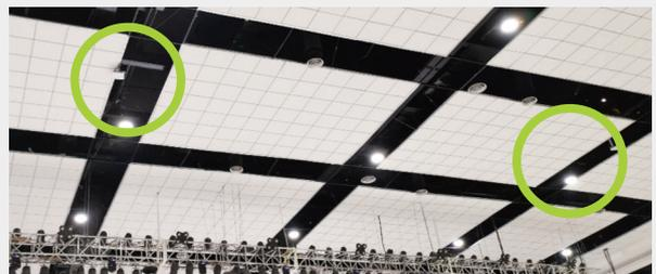
天井設置された2台のアクセスポイント。全エリアをカバーし、1,000台の受信機に音声を届けています。
